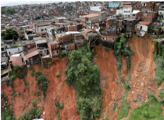
Deslizamento de terra.
